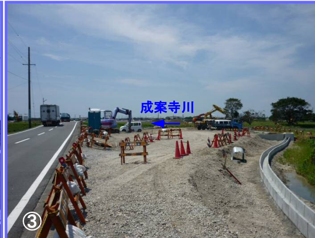
③ 今年度施工予定の成案寺川に架かる橋梁工事のために迂回路を造っています。今年の秋には迂回路が完成します。
