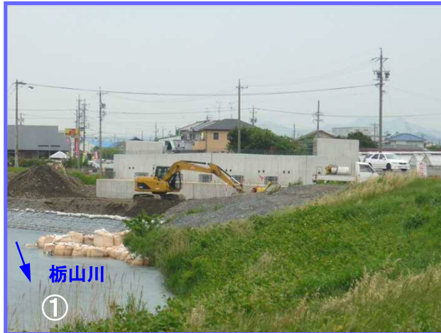
① 栃山川の静岡側の橋台(橋を載せる基礎)がほぼ完成しました。現在護岸工事を行っています。今年の秋から橋桁を架設します。
