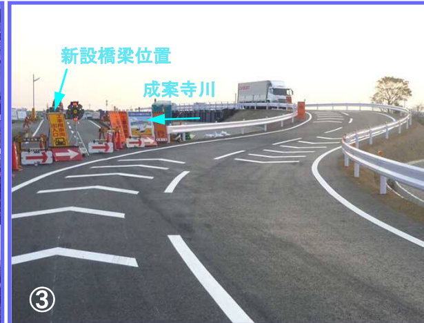
成案寺川に架かる新設橋梁工事のための迂回路が完成しました。これから橋台(橋桁を載せる基礎)工事を行っていきます。
