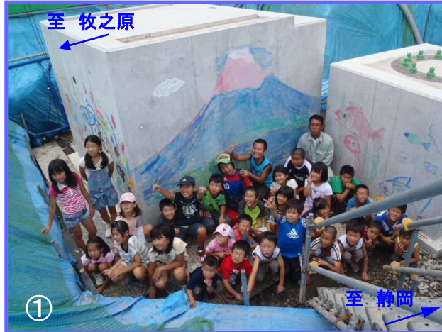
① 惣右衛門地区で施工中の横断歩道橋の基礎コンクリートに、地元の子供たちが記念に富士山など絵を書き入れました。(7月21日撮影)
