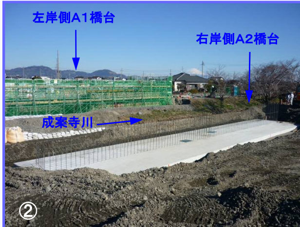
成案寺川に架かる新設橋梁の橋台工事が順調に進んでいます。右岸側でも橋台下部のコンクリート打設が完了しました。
