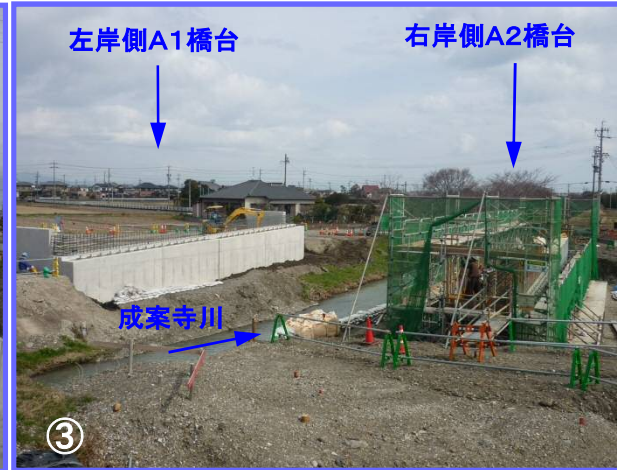
③ 成案寺川に架かる新設橋梁の橋台工事のうち、左岸側では橋台上部のコンクリート打設が完了しました。右岸側も引き続きコンクリート打設します。
