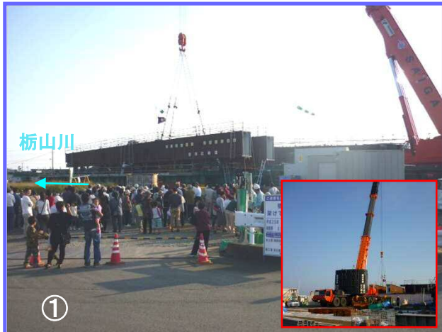
10月中旬から栃山川に橋桁を架設しています。日本最大級の550t吊クレーンを使用しています。11月中旬ごろ架設が完了します。
