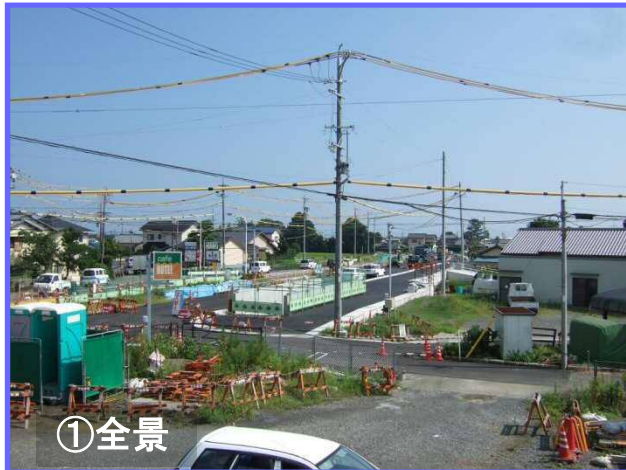
上り線(静岡方面)の車道と歩道のアスファルト舗装を実施しました。9月下旬、現道から整備区間へ交通を切替えます。
