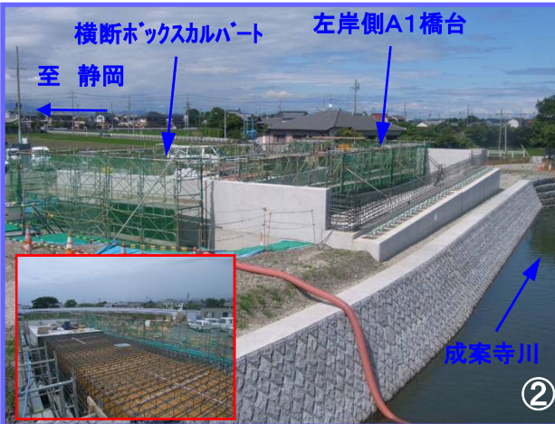
成案寺川に架かる新設橋梁の左岸側橋台の背面では、国道の下を横断するボックスカルバートの施工を行っています。
