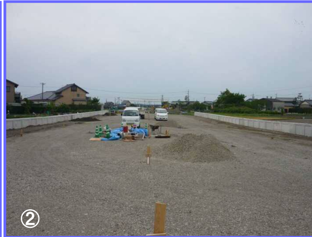
② 前年度から継続している道路新設工事の施工状況です。道路外側に側溝を設置し、田んぼの土を良質な材料に置き換えを行っています。
