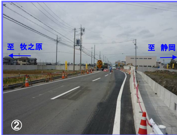
② バイパス本線に取り付く市道取合工事を進めています。引き続き、交差点部及び市道部の造成・舗装工事を行っていきます。
