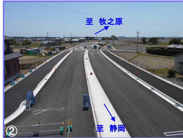
市道寄子橋大島線交差点から市道107号線交差点までの区間を今年度冬に供用予定です。現在舗装工事を進めています。(5月16日撮影)
