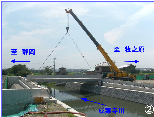
成案寺川に架かる新設橋梁の桁架設を行っている状況です。(7月11日撮影)延長約21mのPC桁を合計34本(約19t/本)架設します。
