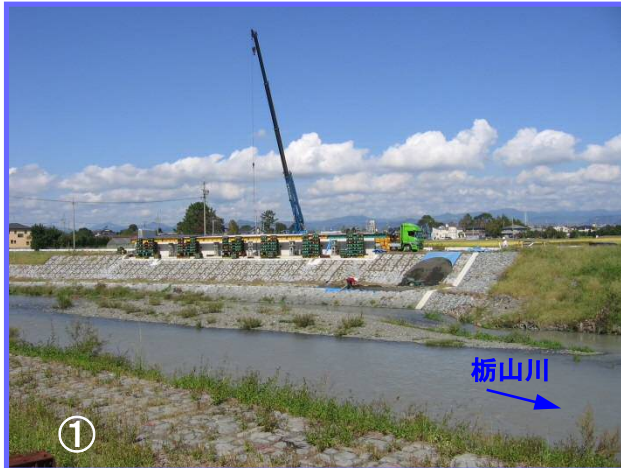
① 10月中旬から11月中旬にかけて、栢山川に橋桁を架設するため、現在準備を行っています。
