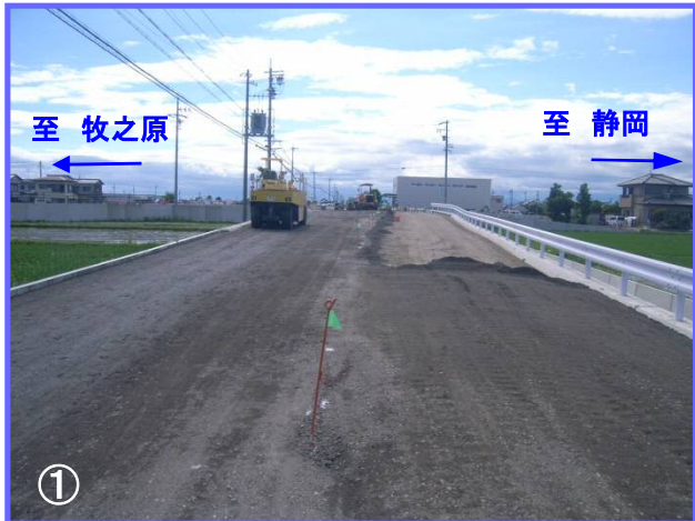
バイパス本線及び取合市道の造成工事が完了し、舗装工事を行っています。
