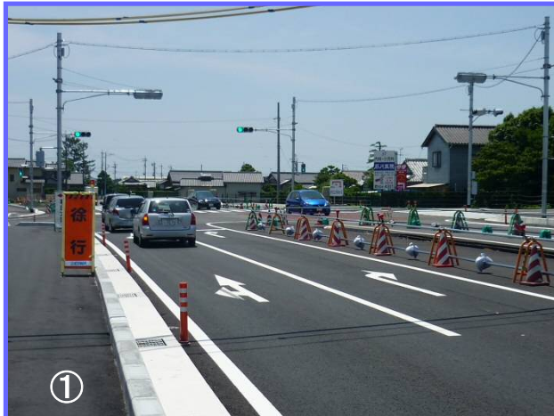
① 6月15日に交通切替えを行い、交差点に信号機が点灯しました。下り線(牧之原方面)と上り線(静岡方面)の車両通行を分離しました。
