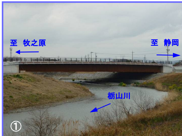
① 栢山川に架かる新設橋梁工事が完了しました。今後は橋梁前後の道路改良工事を行っていきます。
