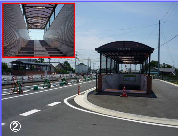
② 地下横断歩道(三和地下道)が完成し、歩行者等の通行が可能になりました。引き続き中央分離帯の施工を行っています。
