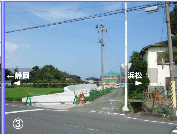
バイパスの取付市道整備状況です。奥には、バイパス整備により、移転になった建設中の住宅が見られます。
