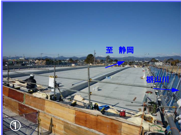
栢山川に架かる新設橋梁工事が順調に進んでいます。桁架設後の床版コンクリートの打設が完了しました。
