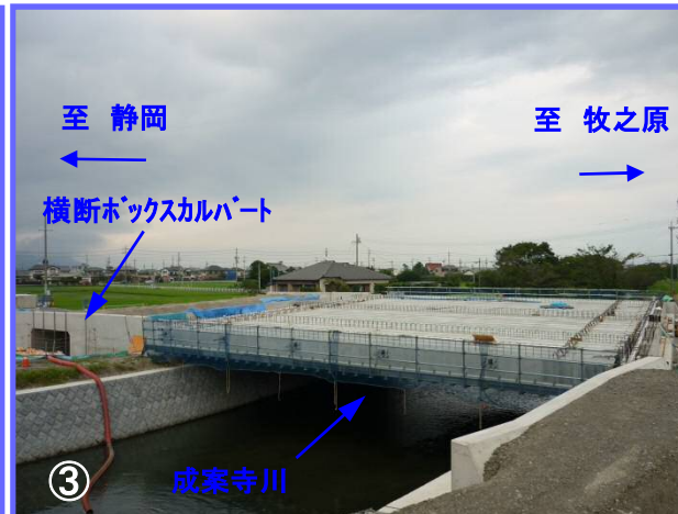
成案寺川に架かる新設橋梁の桁架設が完了し、左岸側では、国道の下を横断するボックスカルバートの施工が完了しました。
