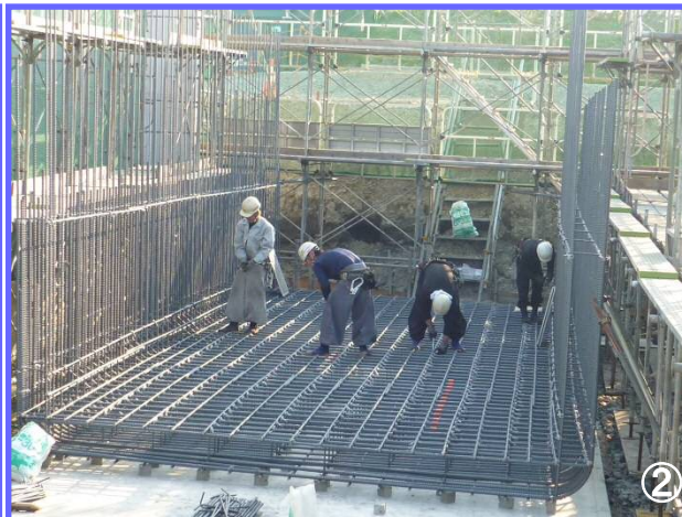
成案寺川に架かる新設橋梁の左岸側橋台の背面では、国道の下を横断するボックスカルバートの施工に着手しました。鉄筋を組み立てています。
