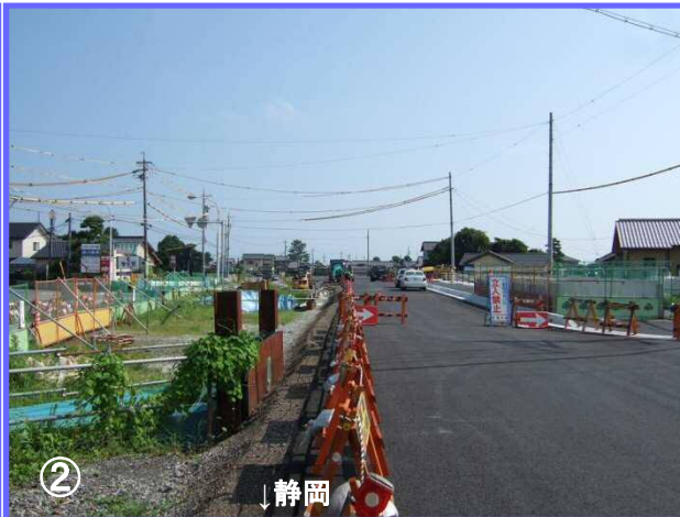
静岡側から見た上り線の整備状況です。これから、警察立会のもと区画線や安全施設を設置していきます。
