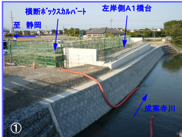
成案寺川に架かる新設橋梁の左岸側では、橋台前面の護岸工事が完了しました。
