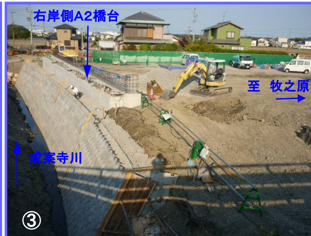
成案寺川に架かる新設橋梁の右岸側では、橋台前面の護岸工事を行っています。
