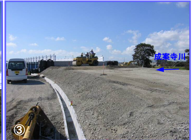
③ 成案寺川に架かる橋梁工事のために迂回路を造っています。仮橋の架設が終わり、橋梁前後の造成を行っています。
