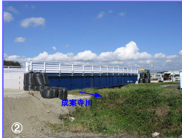
② 成案寺川に架かる橋梁工事のために迂回路を造っています。仮橋の架設が終わり、今月末ごろ迂回路が完成します。
